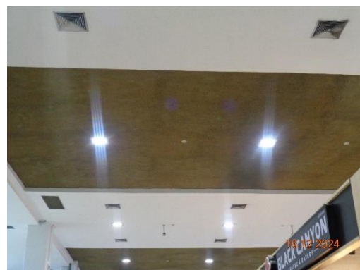
รูปที่ 3-19 บริเวณอาคารผู้โดยสารส่วนที่ติดกับลานจอดรถอากาศยาน มีการติดตั้งกระจก 2 ชั้น ปูพรม และติดตั้งเพดานยิปซัมบอร์ด เพื่อดูดซับเสียง
